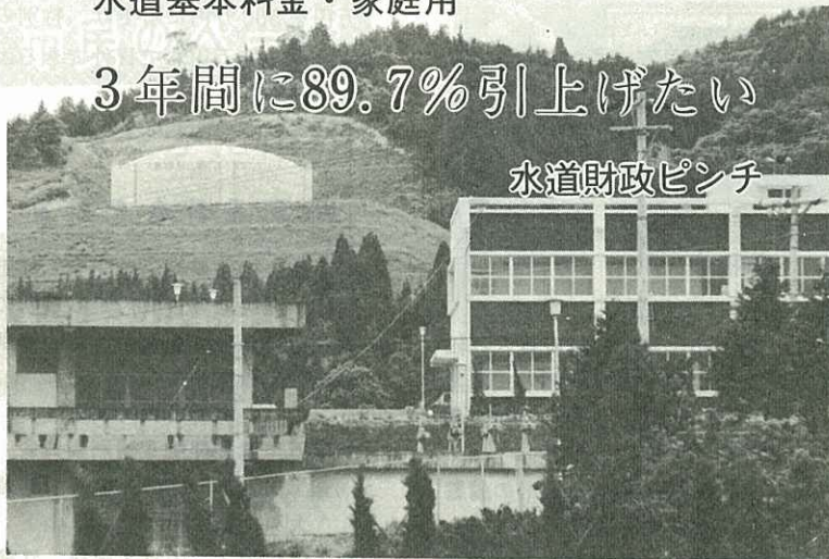
▶供給能力アップをはかる水道施設◀
