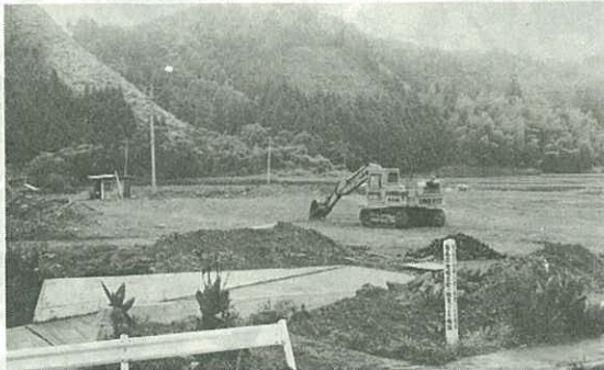
▶ 大川内小学校改築現場 ◀
