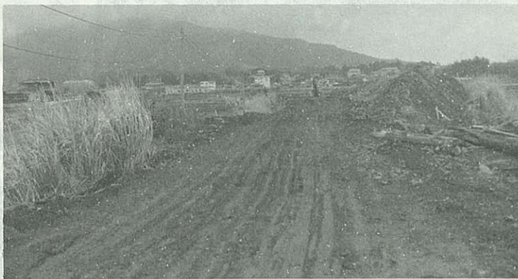
▲ 204号線側から始まった二里～黒川線バイパス工事
