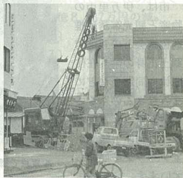
▲下水管の埋設工事をする駅通り
