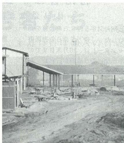
▲立花保育園建設 立花台地に4月開園予定で建設中です。
