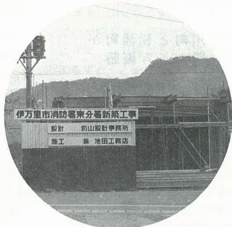
▲消防署東分署建設 市東部の消防、防災体制を充実させるため大川町に建設中で、2月末に完成予定です。
