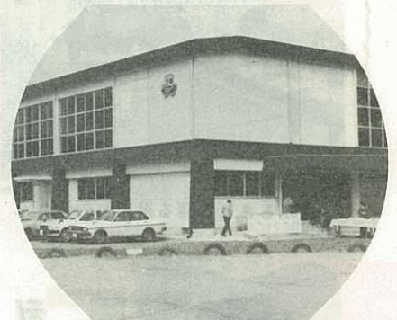
▲新築した牧島小学校体育館
