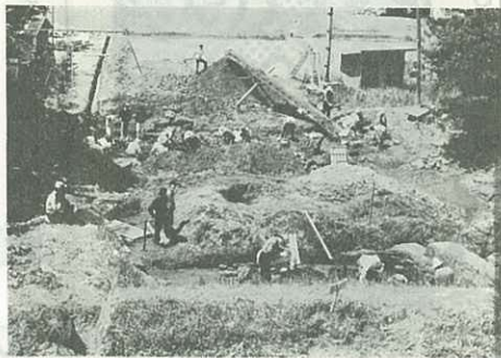
▲黒川町塩屋の金剛島遺跡発掘作業
