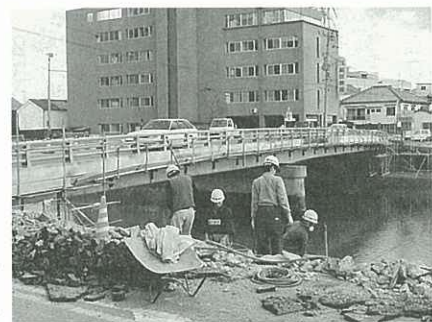
国土庁の事業で整備が進む延命橋
