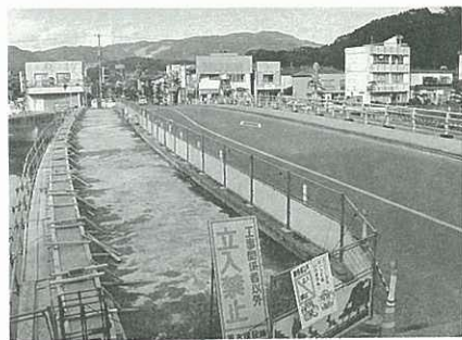
県事業で工事が進む相生橋
