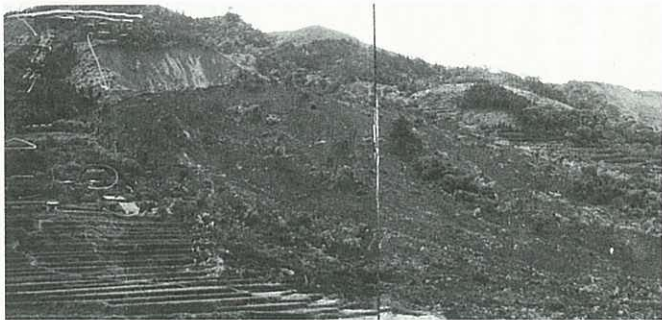
①昭和32年7月に起きた山代町西大久保の地すべり現場
