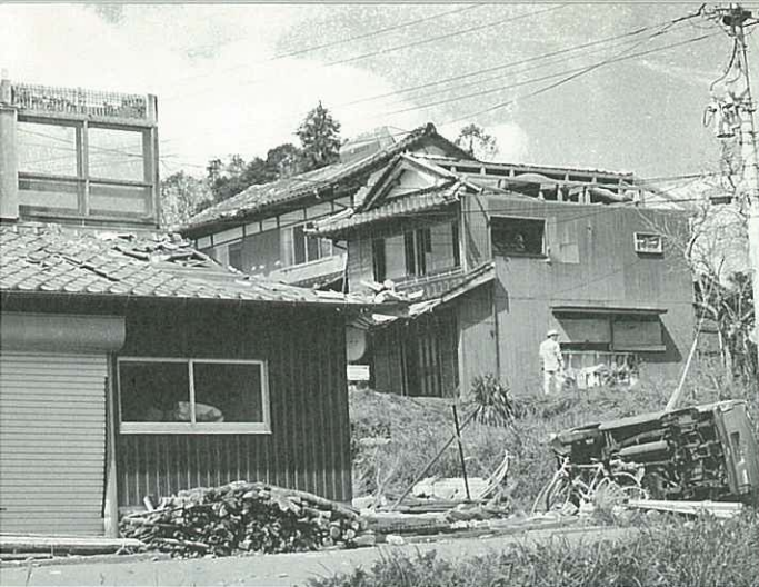
●平成3年9月、台風19号による被害のつめあと(松浦町)
