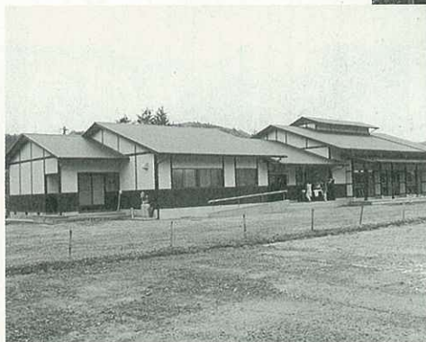
木場簡易水道浄水施設
