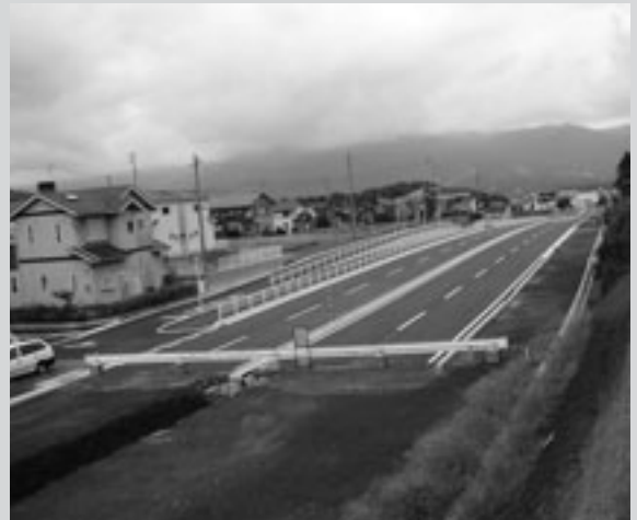
都市計画道路 大坪木須線 (つつじが丘北公園付近)
