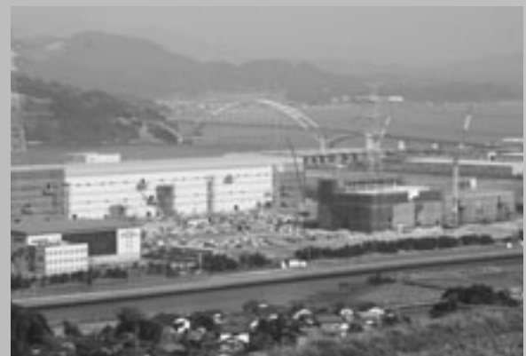
着々と建設が進むSUMCO第5工場
