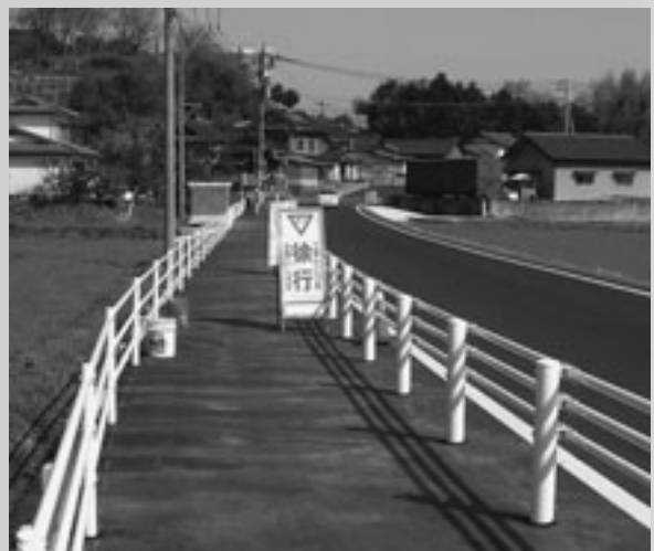
歩道設置が進む黒川松島線
