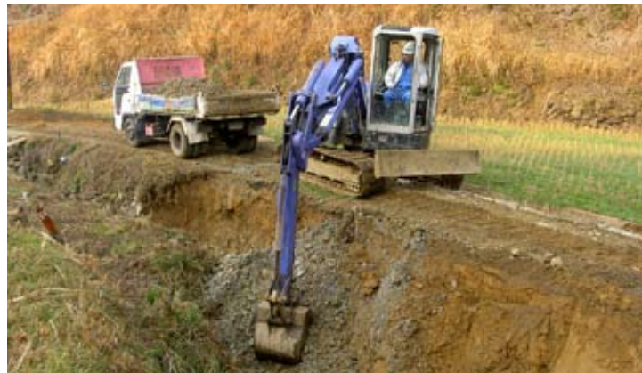
農業用水路の整備工事
