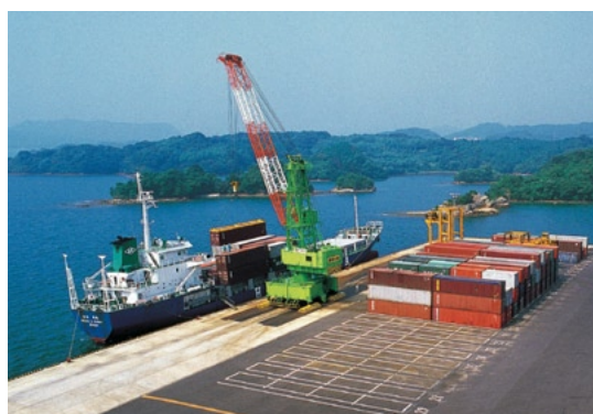
七ツ島コンテナターミナル
