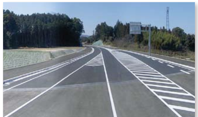
3月に一部開通した都市計画道路・大坪木須線
