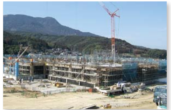
開院に向け着々と建設が進む新統合病院
