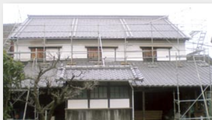
↑屋根を修理中の『前田家住宅』外観
