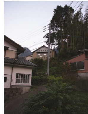
史跡地が接する個所の電柱
