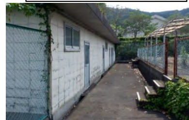
山代中プール附属棟解体
