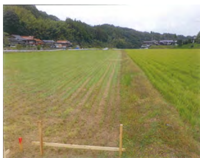
基盤整備工事 着工前
