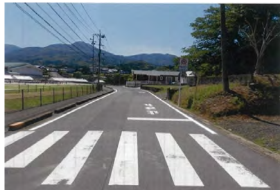
【市道上白幡・長浜線】 区画線（外側線）
