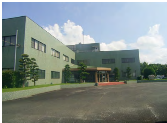
伊万里市浄化センター
