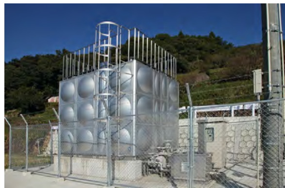
屋敷野配水池
