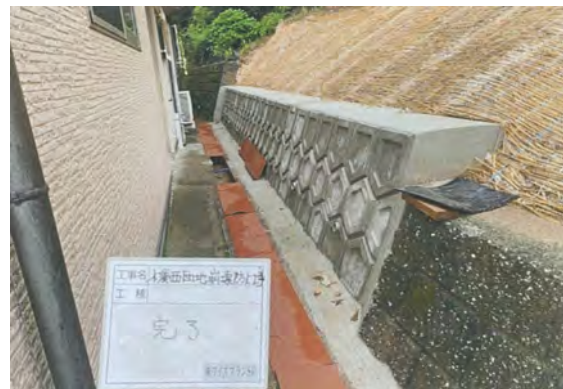
【市有地崩壊防止工事（施工後）】
