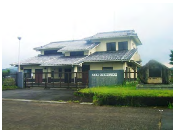
井手野水処理センター
