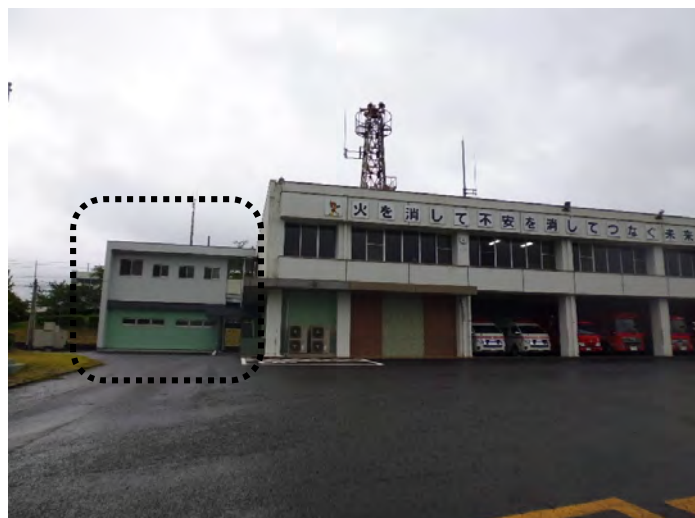
感染防止対策施設整備事業として実施された伊万里消防署の増築工事
