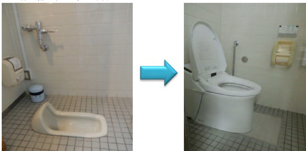
【R4実績（トイレ洋式化15基）和式トイレ⇒温水洗浄便座付洋式トイレ】
