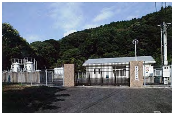
波多津浄水場
