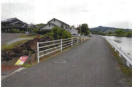
【市道上伊万里・松島線】 防護柵
