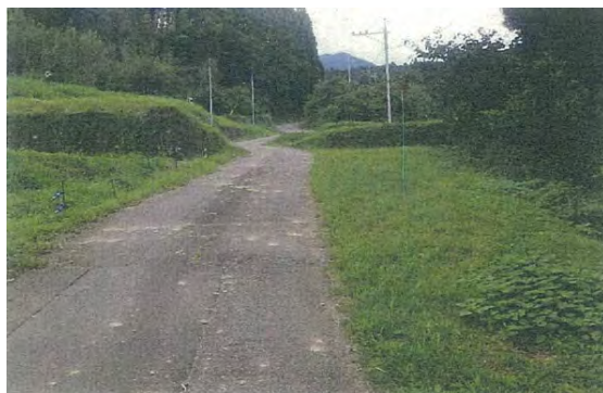
市道東分1号線 着工前
