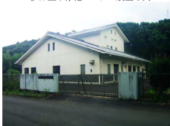
宿地区農業集落排水処理センター
