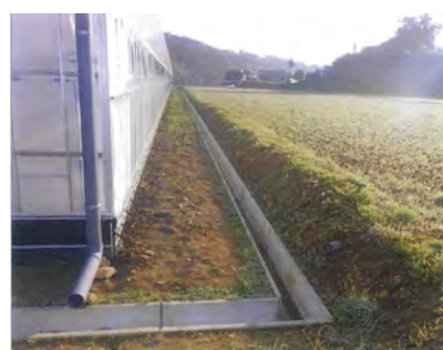
基盤整備工事 完了後
