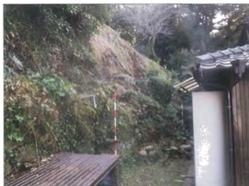
●工事着工前（善道）
