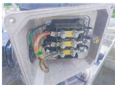
【クーリングタワー 破損箇所 修理後】
