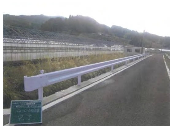
【市道川東22号線】 防護柵
