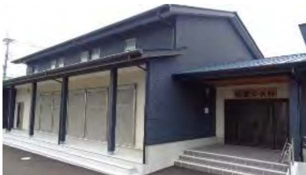
完成した川東公民館
