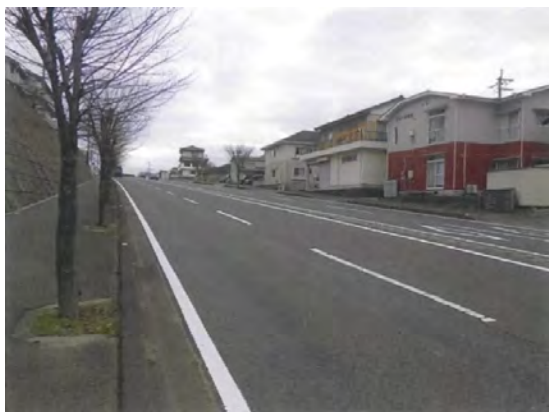
【市道大坪・松島線】 区画線（外側線）
