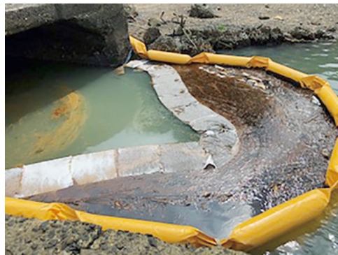
↑油の流出により、オイルフェンスを設置した水路
