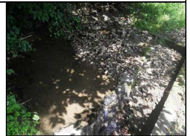
N10 : 基幹林道脇排水
