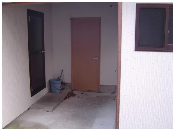
【別棟建物 共用廊下】
