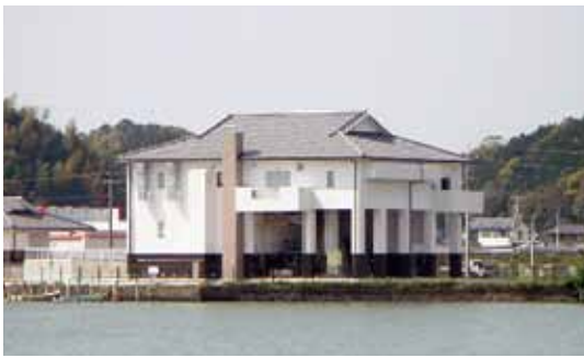
↑伊万里川の対岸から見た馬伏雨水ポンプ場の全景
