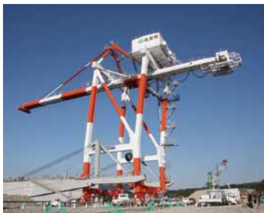
↑平成 25 年 4 月に供用開始したガントリークレーン
