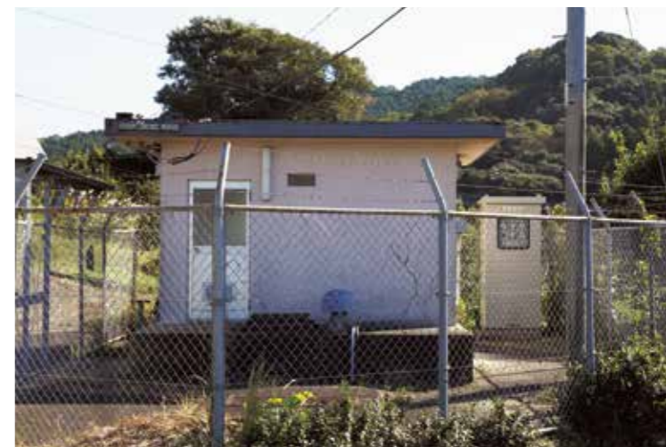
黒川送水ポンプ場
