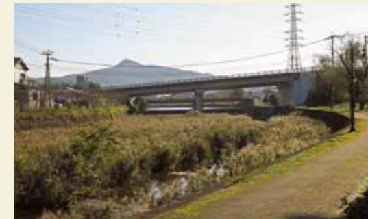
旧常入井手跡(河川改修により今は存在しない)
