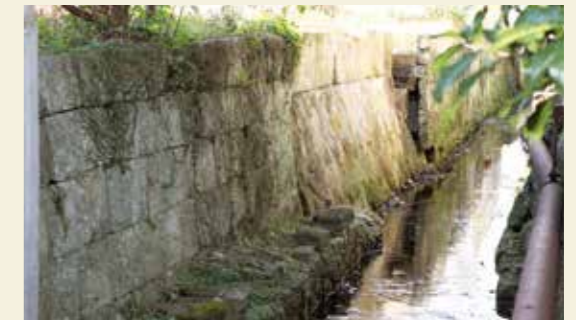
市街地に残る水路の石垣
