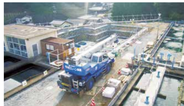
5次拡張施設の解体と生物接触ろ過池建設 (既存施設を運転しながらの更新作業)
