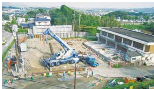
4次拡張施設の解体と膜ろ過施設の建設
