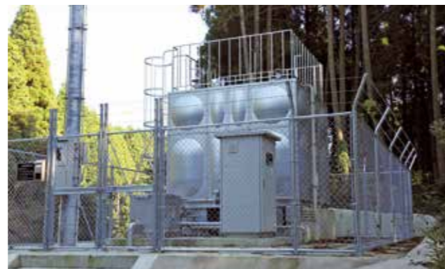
大野岳配水池
