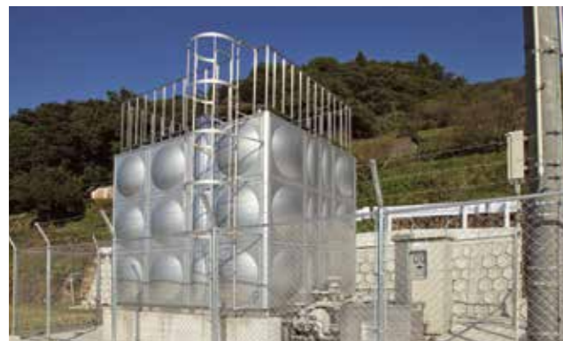
屋敷野配水池
