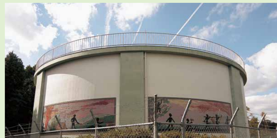
3号配水池：3,500m 3
