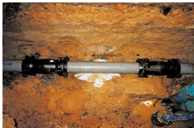
VSジョイントφ100mmを使用し修理完了
