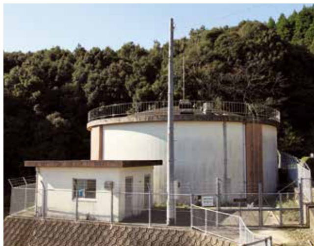
南波多配水池
