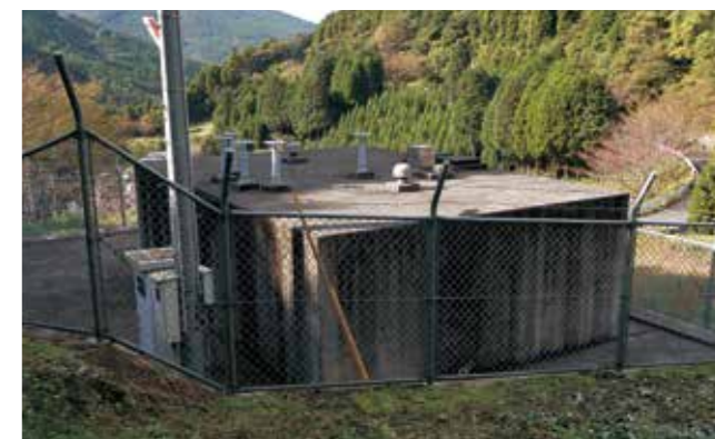
大川内山配水池
