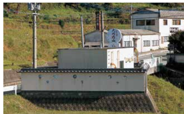
大川内山送水ポンプ場
