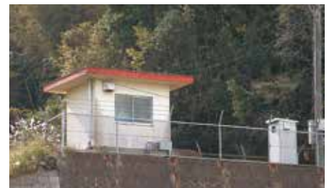
中田送水ポンプ場
