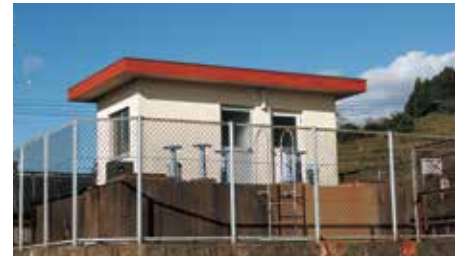
古子低部配水池・送水ポンプ場
