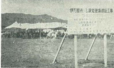
し尿処理場建設現場
