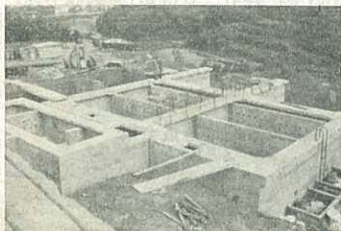
【写真】三里町川東に建設中の浄水場施設
