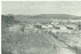
【写真】麻生鉱業から買収した土地に建設中の市営住宅（久原）
