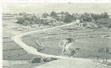
【写真】完成した木須町・市道川久保～海面線・幅員5メートル・延長312メートル
