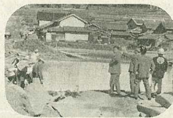
【写真】市長黒川県道工事を視察
