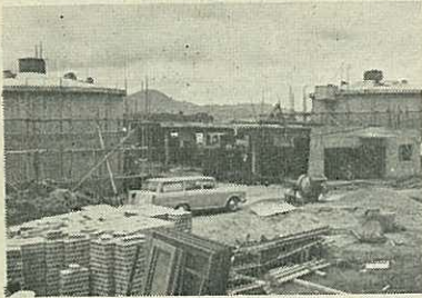
完成ちかいし尿処理場
