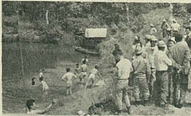
上原ため池の応急作業
