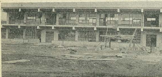
完成した東山代小学校の校舎
