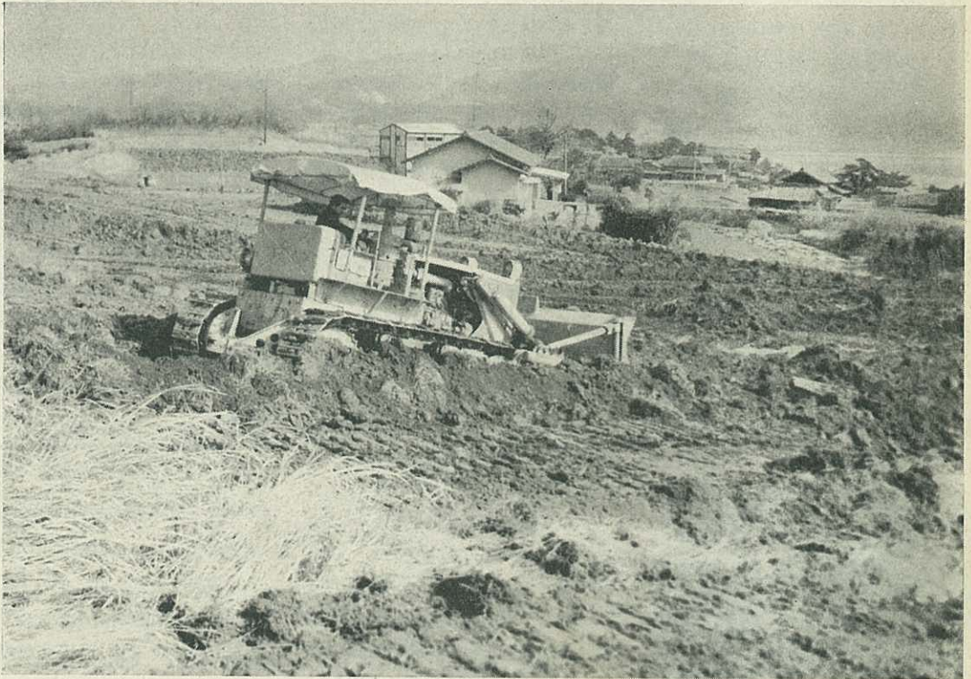
(S 41・2・14 長浜団地造成工事を写す)
