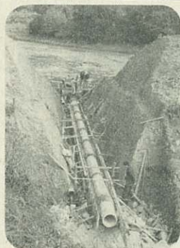
四太郎ため池の底樋工事
