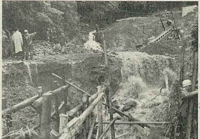
7月2日、東山代町久保の二坑ボタ山がくずれ始め、付近の民家20戸が危険になったため、地元消防団・警察機動隊・伊万里土木作業員など184人が出動し、土のう積みや水切り作業で災害を防ぎました。
