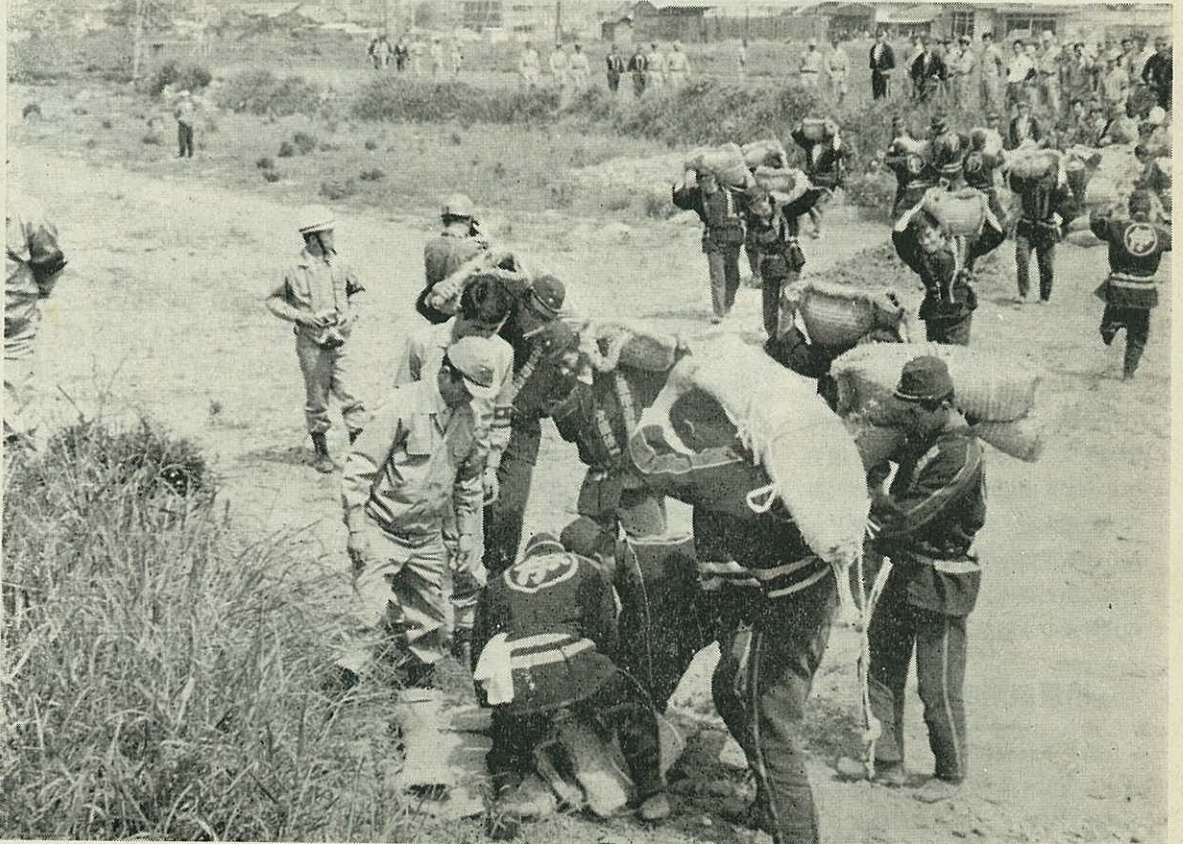
—— 防災訓練で伊万里川堤防補強のため土俵を積む消防団員 —— (5月23日 岩栗橋上流で)
