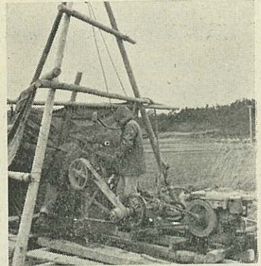
瀬戸町早里でのボーリング
