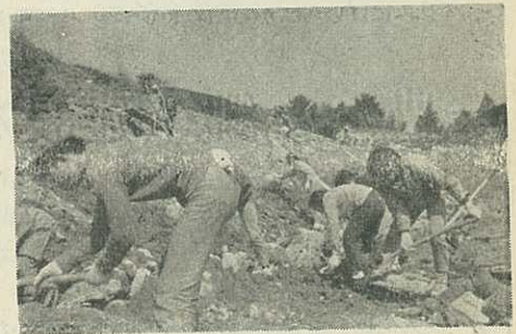
▷道路工事に汗を流す青年奉仕隊◁
