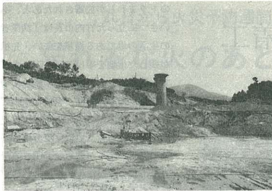
▶ 工事を再開する長浜工業用水ダム ◀
