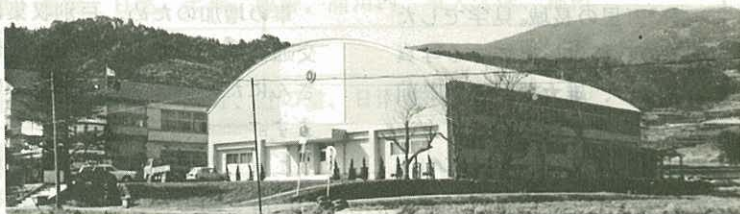
▲山代東小学校体育館が完成 総工費6,095万円をかけ緑の屋根のきれいな体育館が完成、3月12日に落成式が行われました。(3・24)
