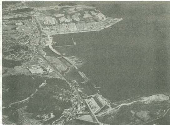
● 伊万里工業団地建設中 (山代町楠久から久原かけた地先に130億円
