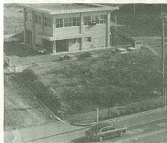
▲休日急患センター建設予定地
