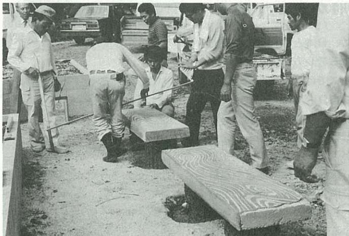
○ベンチの据え付け作業
