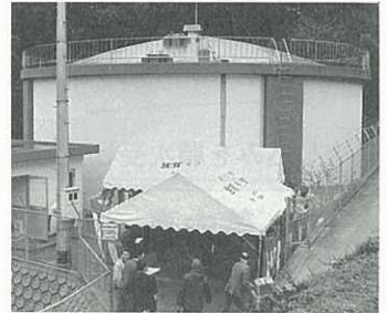
◎通水式会場の南波多配水池
