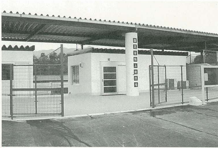
① 国見台陸上競技場正面入口
