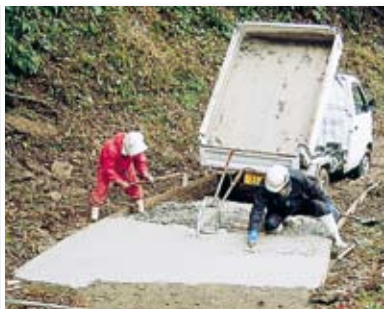
→ 市道の舗装補修工事を行うわがまちの職人さん
