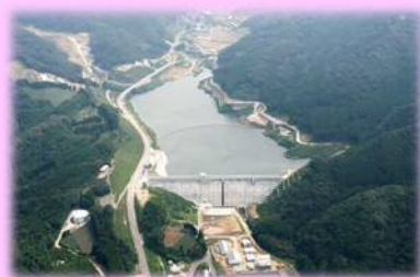
井手口川ダムと大川浄水場
