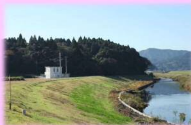
松浦川と取水ポンプ場
