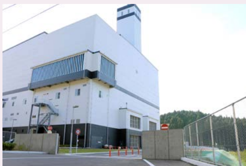
佐賀県西部広域環境組合一般廃棄物処理施設 (愛称：さが西部クリーンセンター)
